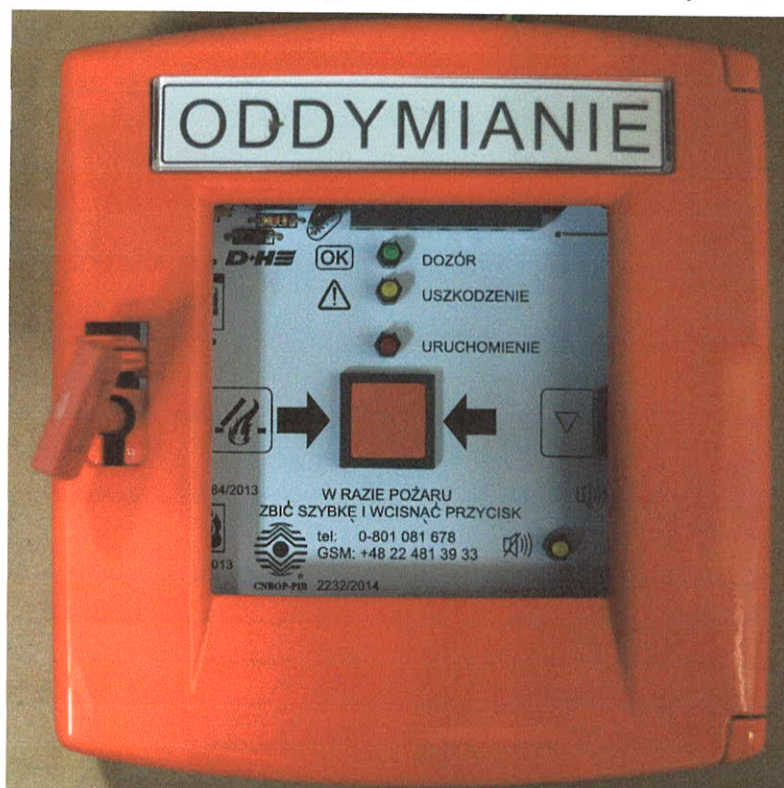
Rys. 1. Ręczny Przycisk Oddymiania typu RT 45-ST-PL
