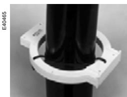
Montage sur les câbles MT.
