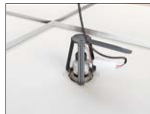
4. Podłącz zasilacz i wsuń przewód w uchwyt kołpaka.
