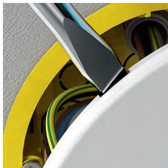
Usuwanie zatrzaskowej pokrywy puszki rozgałęźnej
