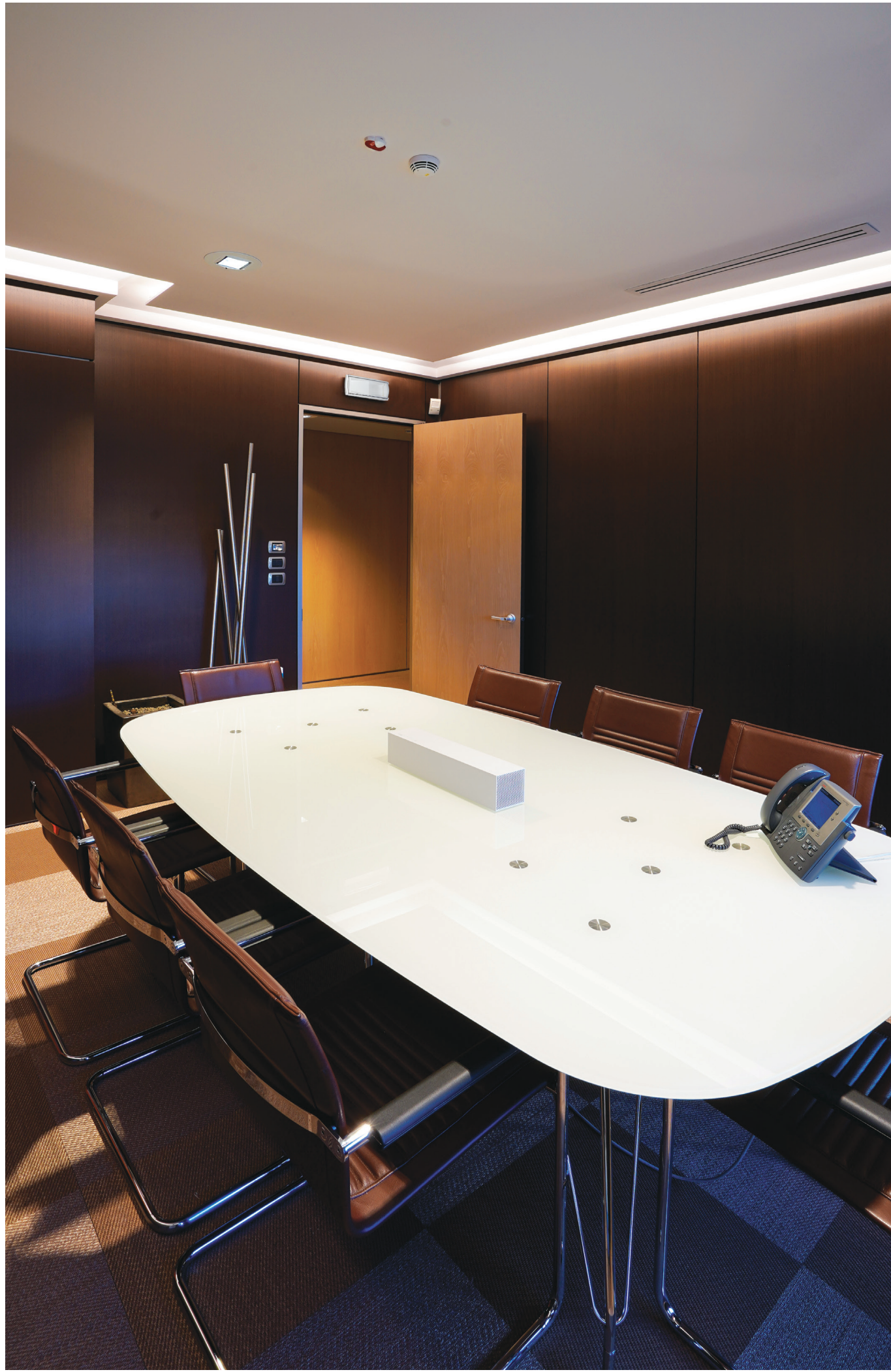
oprawy oświetlenia awaryjnego
